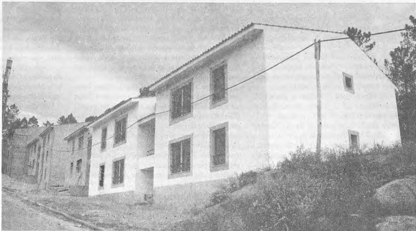
A construção das moradias da Cooperativa está no fim!
